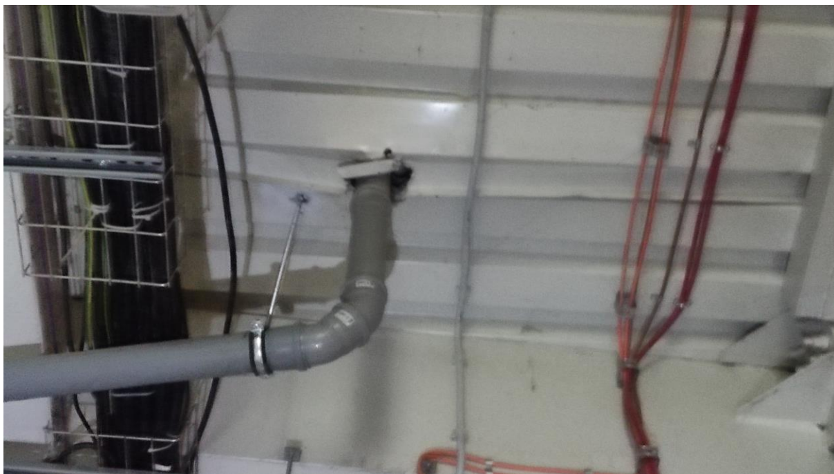
Foto. č.18 Detailní pohled na střešní konstrukci ochozu, prostup TR plechem a střechou necitlivě proveden, TR deformován
