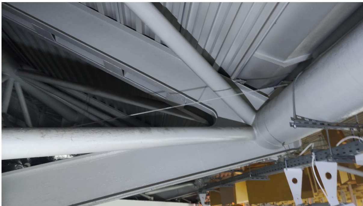
Foto. č.13 Detailní pohled příhradovou konstrukci – obvodový prstenec a spodní líc dešťového žlabu
