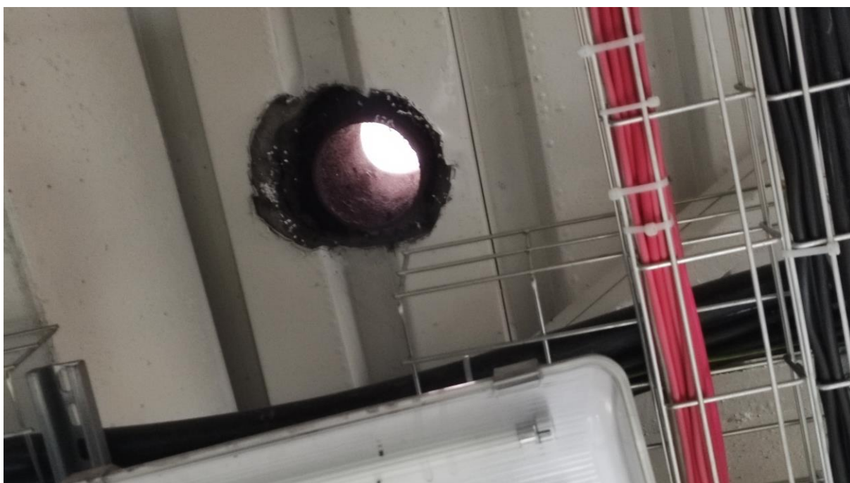
Foto. č.17 Detailní pohled na střešní konstrukci ochozu, prostup TR plechem a střechou bez zakrytí stříškou
