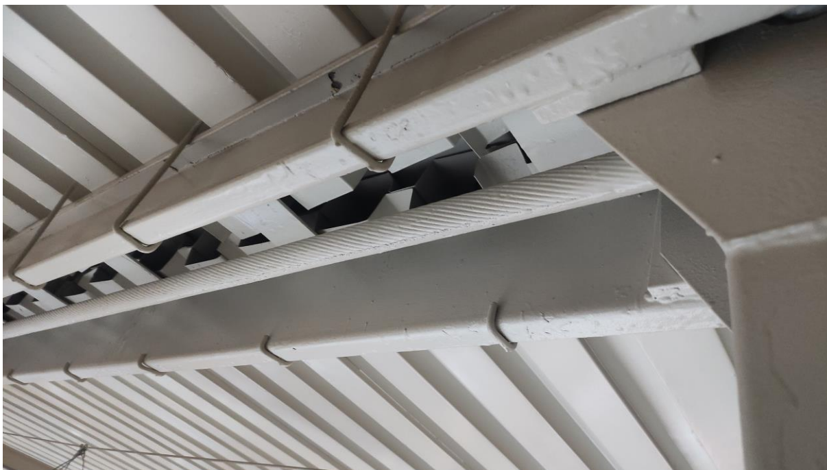
Foto. č.5 Detailní pohled na spodní líc střešní konstrukce – patrný VSŽ plech, vedení horního nosného lana, vaznice, kotvení VSŽ plechu
