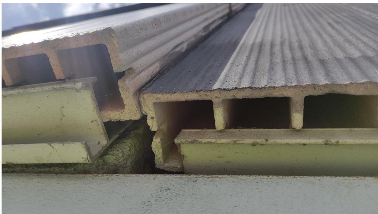
Foto. č.19 Detailní pohled na obvodový plášť ochozu z keramických tvarovek kotvených na ocelové paždíky a pomocnou OK
