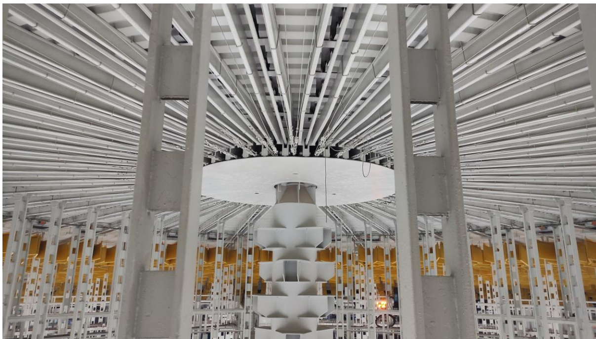
Foto. č.8 Detailní pohled na rozpínací vřeteno a kotevní prstence horních lan
