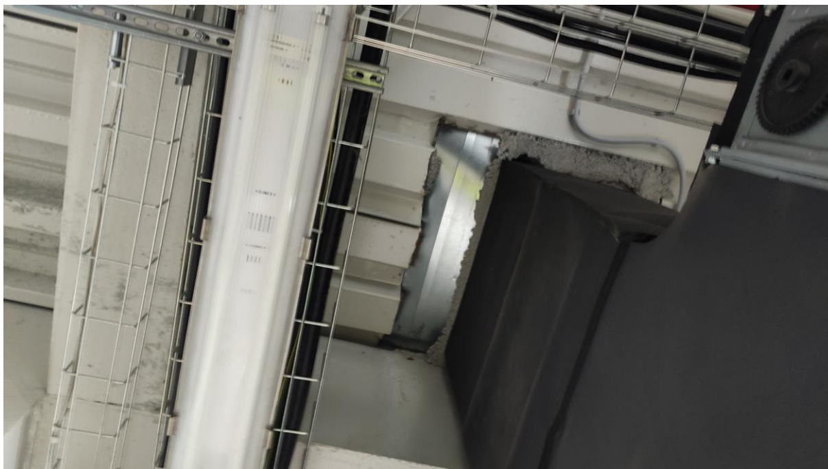
Foto. č.16 Detailní pohled na střešní konstrukci ochozu, prostup TR plechem bez podepření ocelovou výměnou
