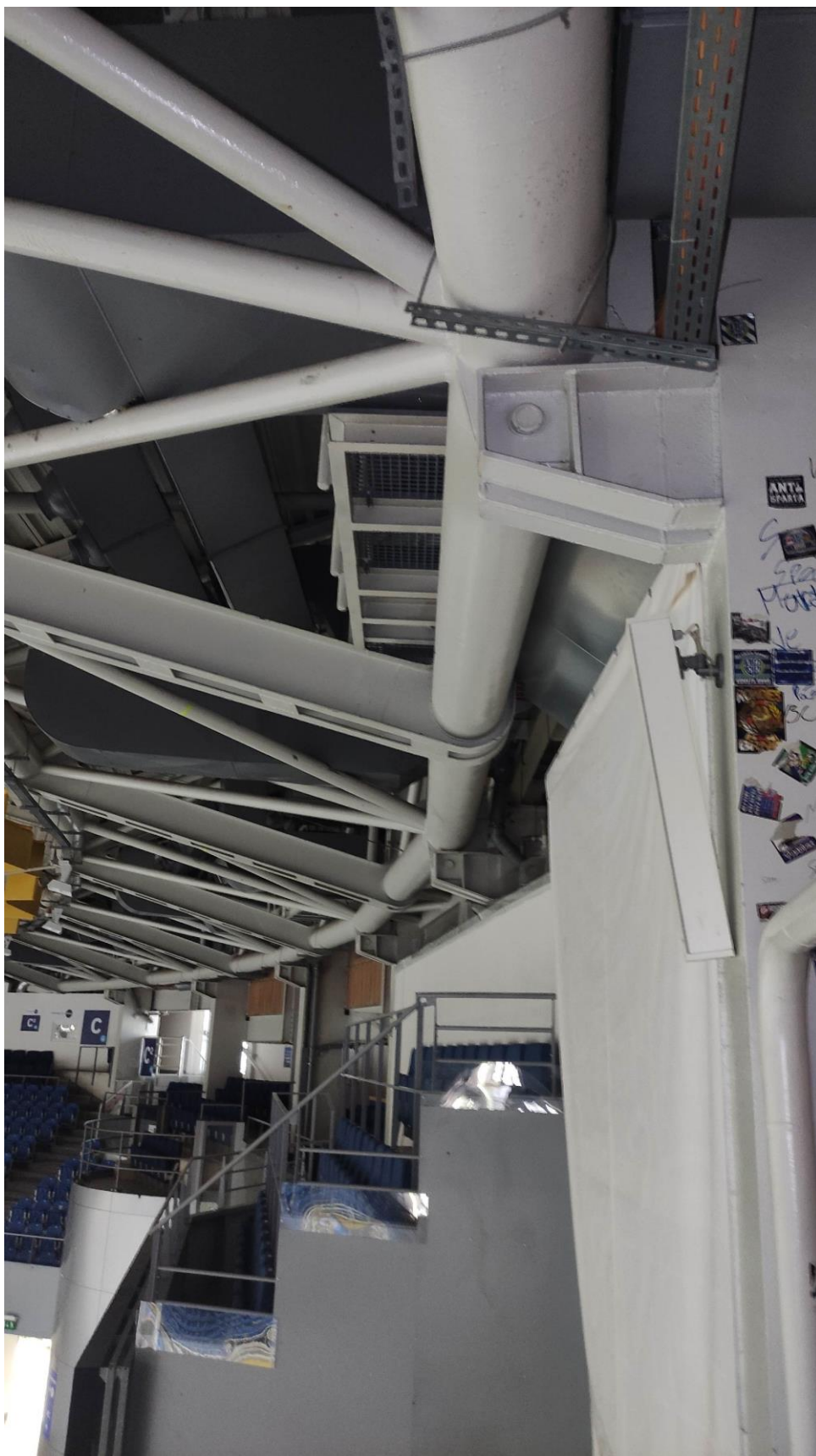
Foto. č.15 Detailní pohled příhradovou konstrukci – obvodový prstenec a jeho uložení na sloupy
